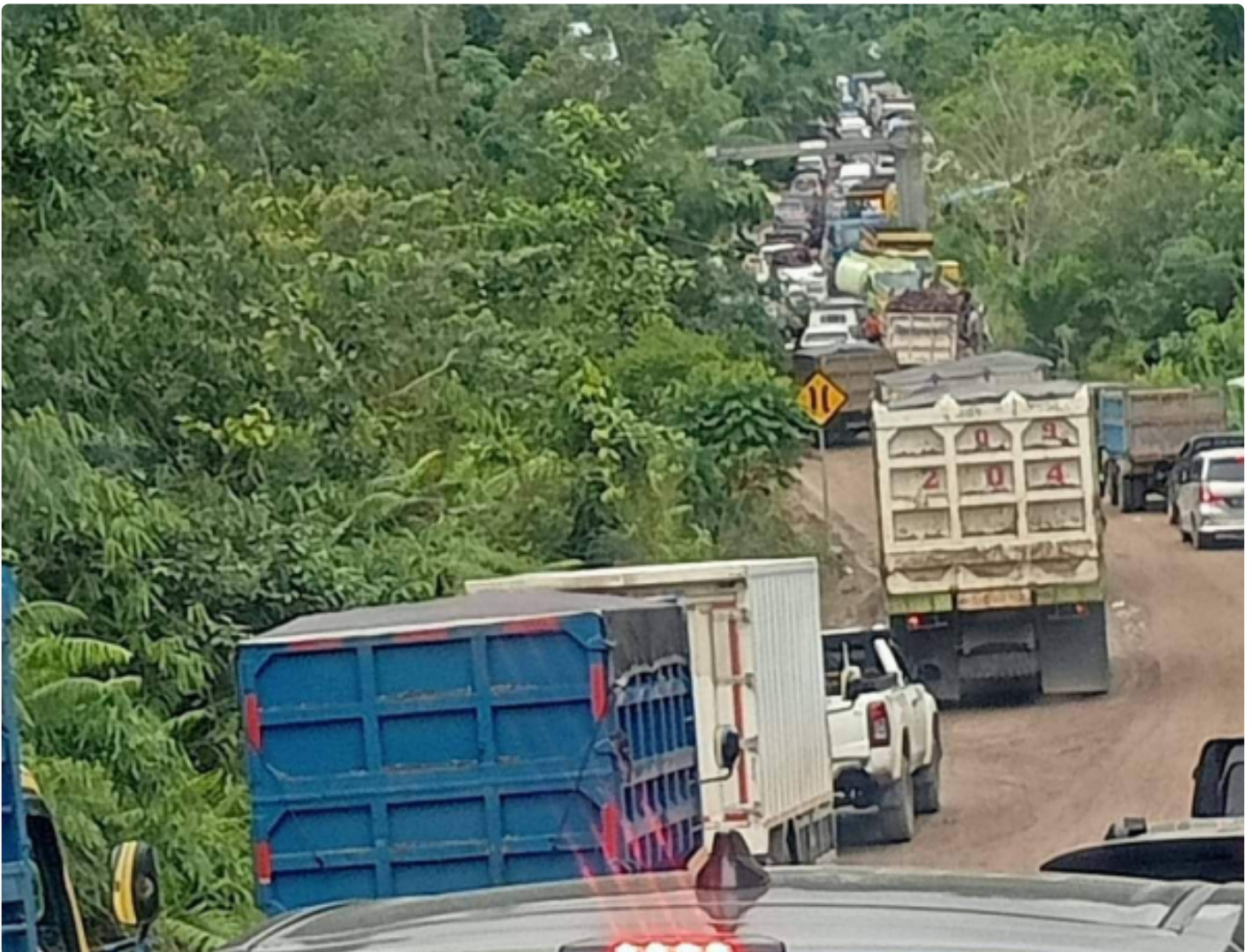
Gambar : Kondisi Ruas Jalan Kuala Kurun Kabupaten Gunung Mas Macet Parah dan Rusak, Foto diambil tanggal 5 Juli 2022
